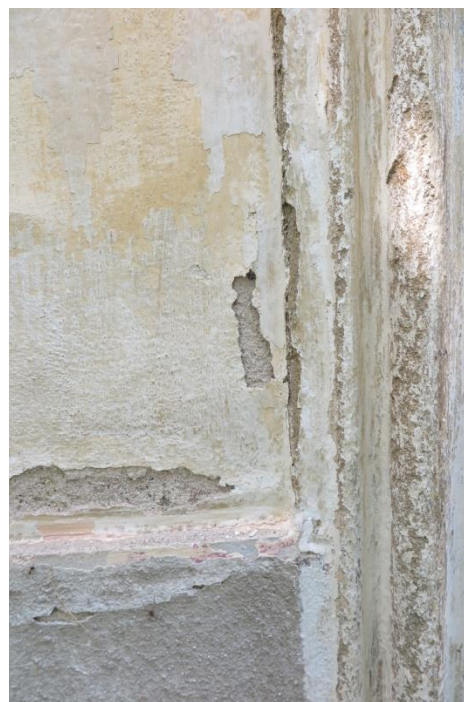
Detail profilace soklu a portálu
