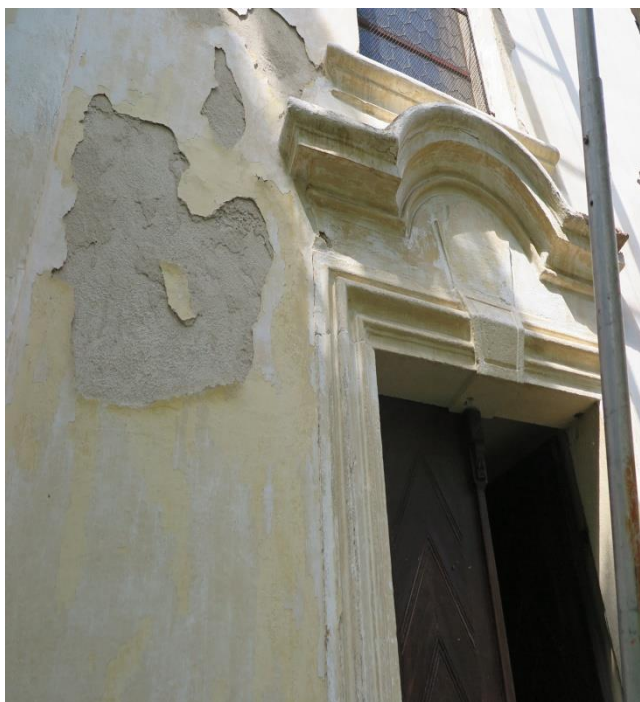
Detail poškození omítek a supraporty
